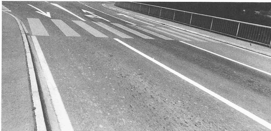
Bild C2. Übersicht Blick Richtung Kreuzung. Kommentar vgl. Bild C1
