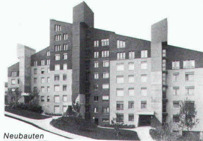
Neubauten in Wilen, SG. Überbauung mit Holz/IV-Fenstern.
