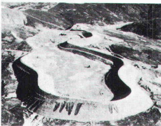
Bituminöse Aussenhautabdichtungen - eine unserer Spezialitäten
