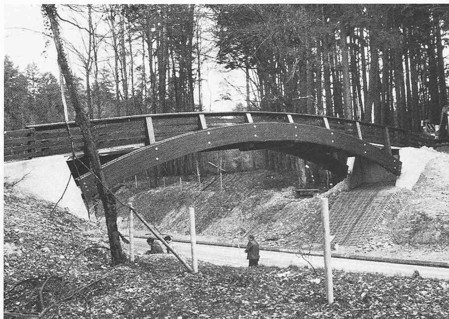
Ansicht der neuen Holzbrücke
