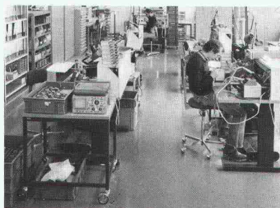
Werkhalle der Stäfa Control, Stäfa
