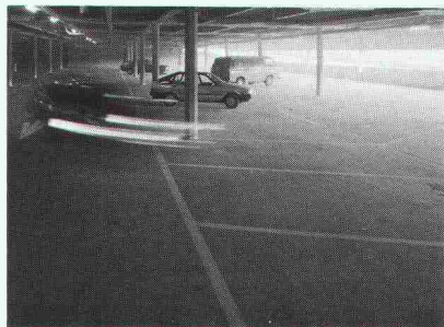
Parkdeck Glattzentrum, Wallisellen
