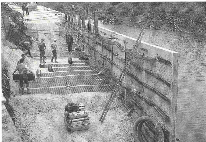
Bauvorgang. Vorfabrizierte Betonelemente mit eingesetzten Geogittern können leicht und zeitsparend eingesetzt werden
