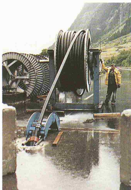
Bild 15. Vorspannung Überbau, Einziehen der Kabel Bildautor: K. Lüpold VSL
