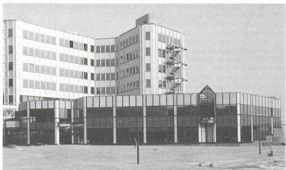
Bild 16. Data Processing Center in Luxemburg
