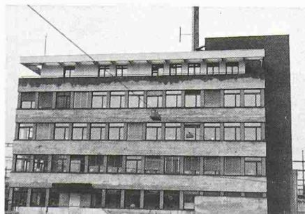
Bild 1. Gebäude-Ansicht. Die Stahlbetonstützen zwischen den Fensteröffnungen müssen auch den Stockwerk-Schub aus Windlasten aufnehmen. Diese Stützen bilden zusammen mit den Geschossdecken eine relativ biege-weiche Rahmenkonstruktion
