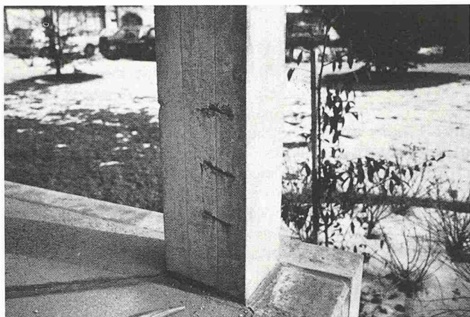
Bild 3. Der Armierungskorb hat sich schräg gestellt, Baujahr: 1970
