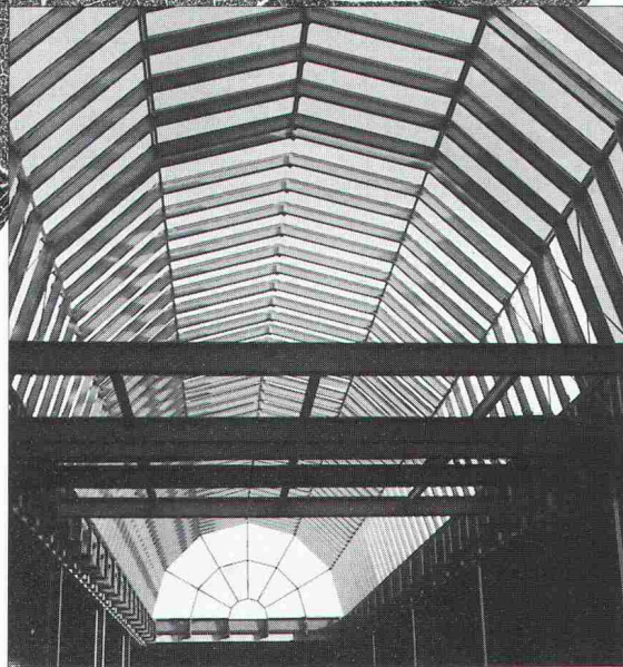
Stahl- und Industriebau
