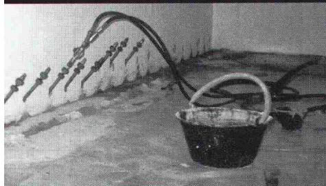
Elastische Abdichtungs-Injektion-Rascotex in einer Zivilschutzanlage.
