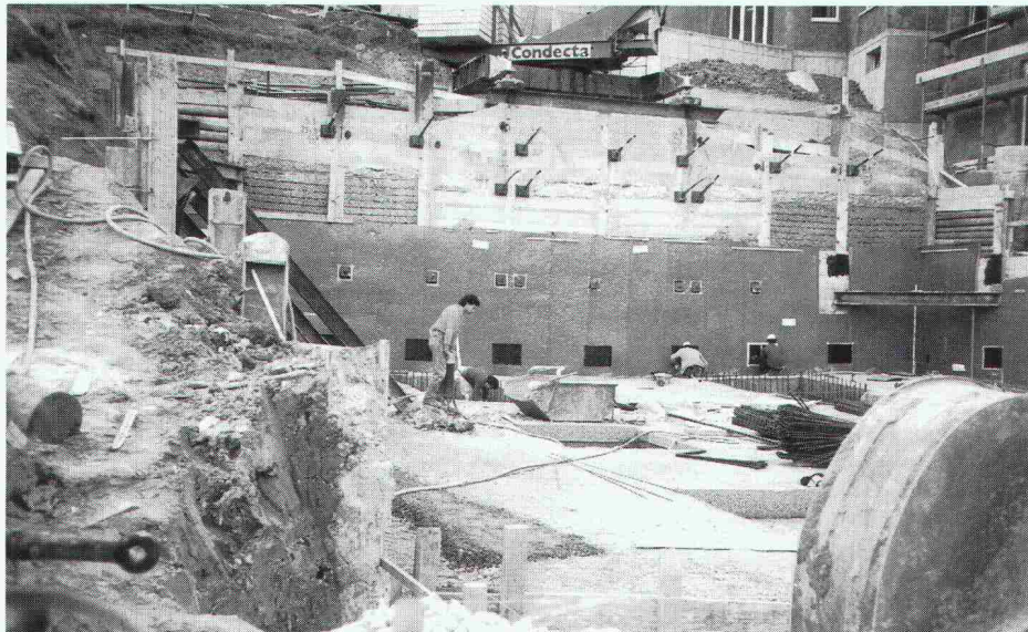
Raumgewinn dank Enkadrain CK bei der Überbauung Haltenreben in Winterthur-Wülflingen (Zani Generalunternehmung AG, Winterthur)
