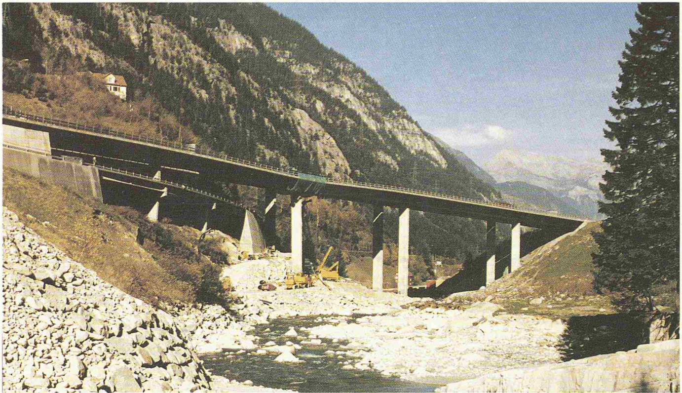
Bild 2. Gesamtübersicht der Reussbrücke in Richtung Nord, Reusslauf, Oktober 1987
