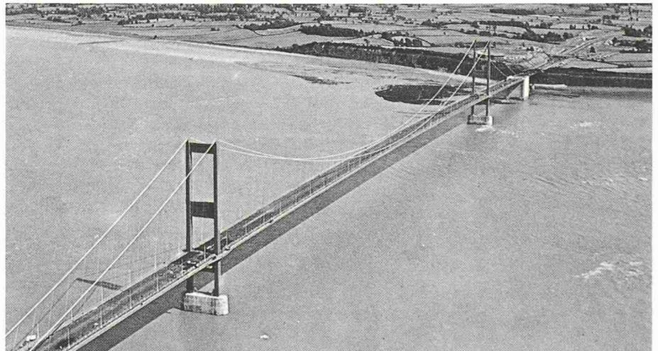
Brücke über die Severn-Mündung, Spannweite 1080 m, 1966
