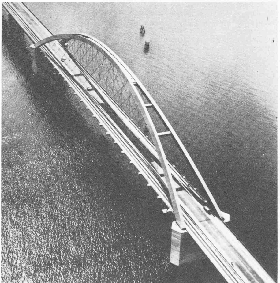
Brücke über den Fehmarnsund (1963)
