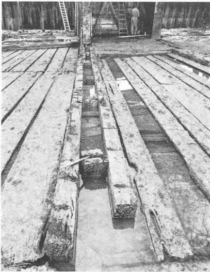
Fallboden der Öffnungen 2 und 3
