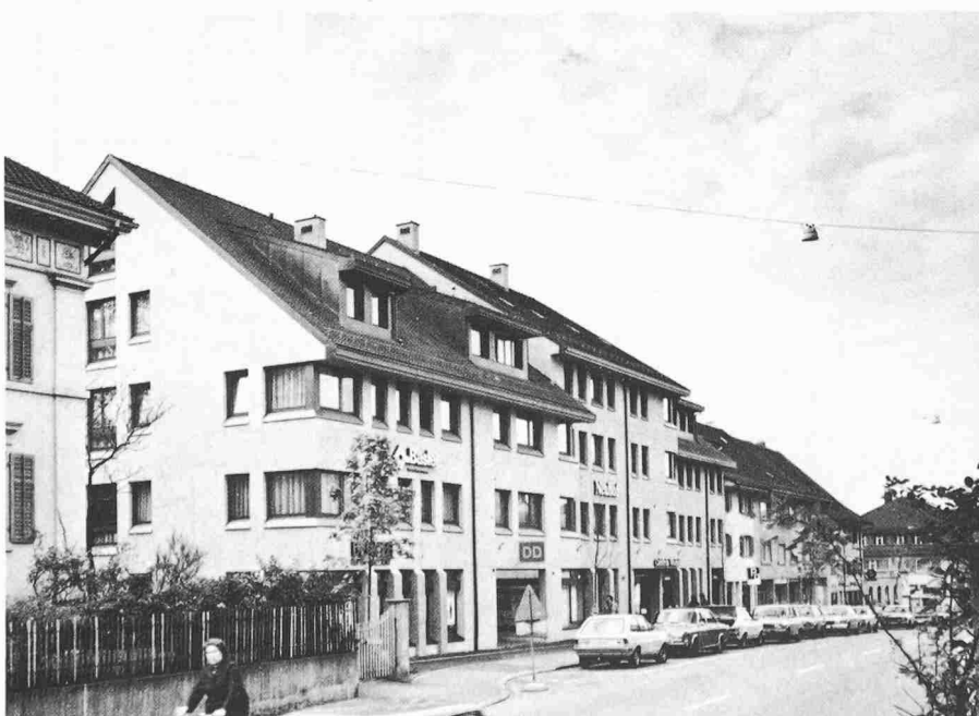
Die Neubauten von Norden aus der Kasernenstrasse
