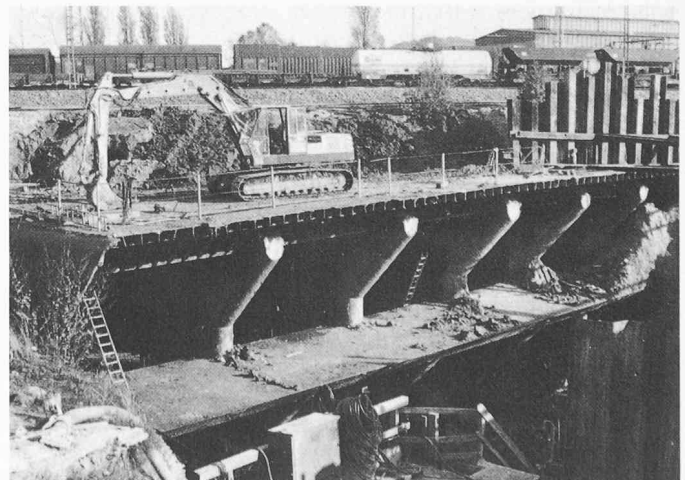
Bild 19 (unten). Einpress-tunnel von Bild 18 nach dem Durchstich
