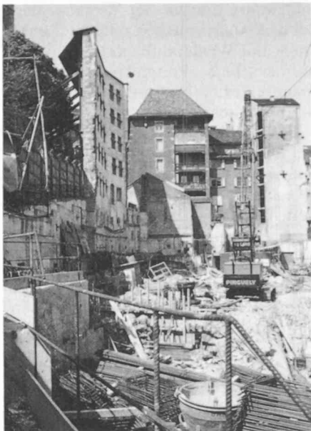
Genf, Altstadt, Sanierung
