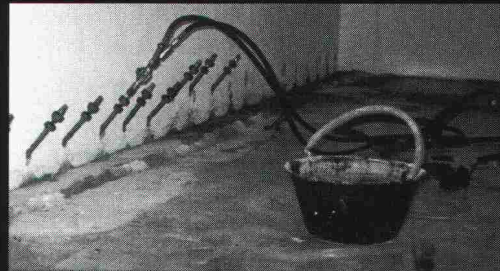
Elastische Abdichtungs-Injektion-Rascoflex in einer Zivilschutzanlage.
