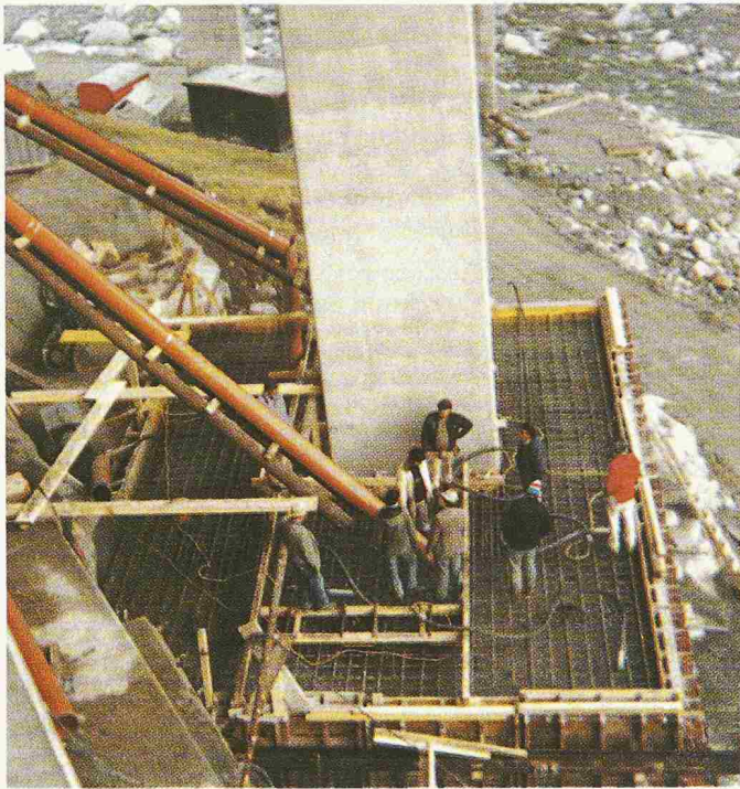
Bild 6. Betonieren neues Fundament R. Kalbermatten
