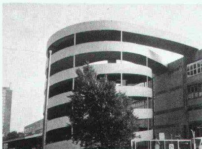
Rampe Parkhaus Migros Herdern
