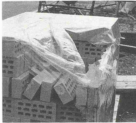
Bild 1. Durchfeuchtung einzelner Backsteine bei unsachgemässer Lagerung während Arbeitsunterbrüchen
