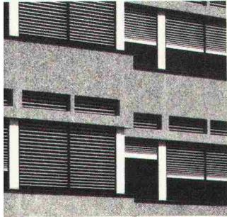
Die **Ganzmetall-Rafflamellenstore** wurde für höchste Anforderungen entwickelt und ist die ideale Kombination der Eigenschaften von Rolläden und Rafflamellenstoren.
