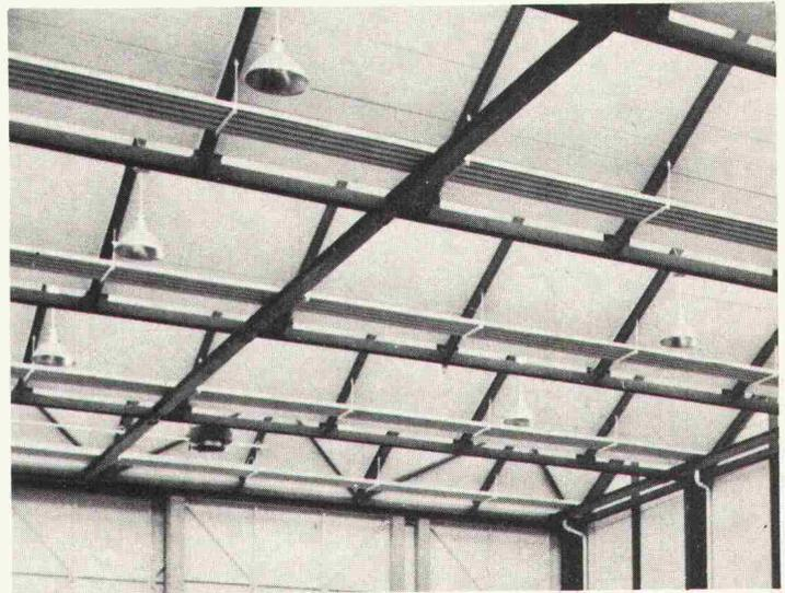
DURISOL-Dachelemente bestehen aus einem hochisolierenden Körper, der oben durch eine abtallochierte Feinbetonschicht geschützt wird. Daraus resultiert die hervorragende thermische Isolationsfähigkeit. Der Erfolg der DURISOL-Dachelemente beruht
