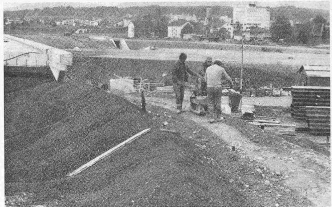
Bild 8. Verdichten des seitlichen Stützkörpers mit dem Plattenvibrator AT 2000
