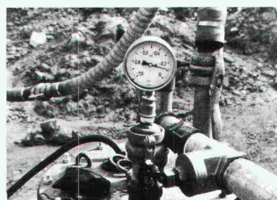
Wasserhaltung mit Vakuumbrunnen
