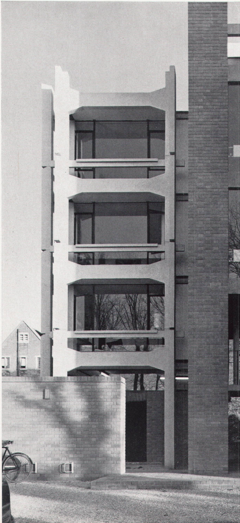
1 Fassadendetail mit H-förmigen Elementen Détail de la façade avec éléments en H Façade detail with H-shaped elements
