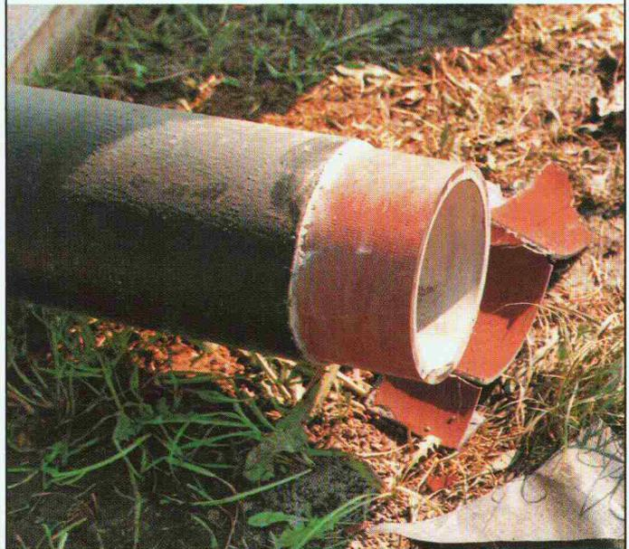
Der Installateur bereitet die Gummimanschette für den Muffenschutz zum Einbau vor. Deutlich ist am Rohr mit der roten Schutzkappe erkennbar, dass das Spitzende auf Einstecktiefe nicht mit dem FZM-Panzer beschichtet wird.
