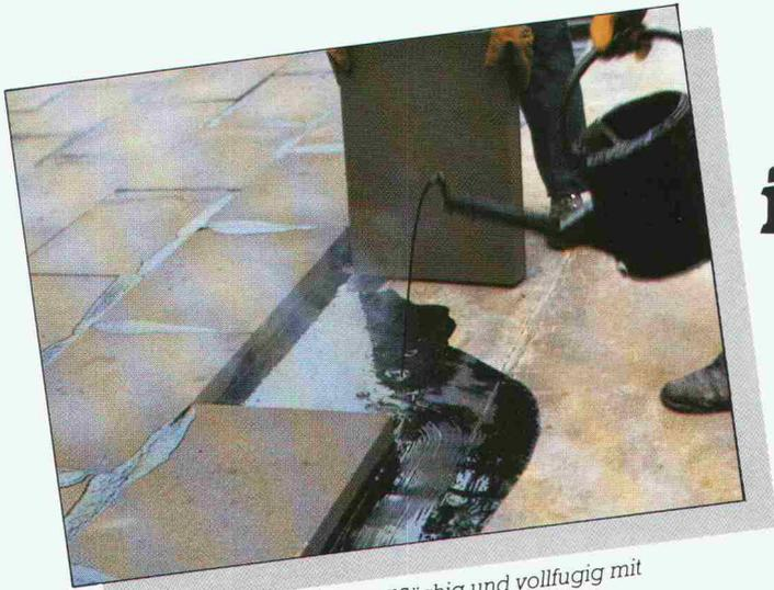
▲ FOAMGLAS®-Dämmstoff vollflächig und vollfugig mit Heißbitumen verklebt.
