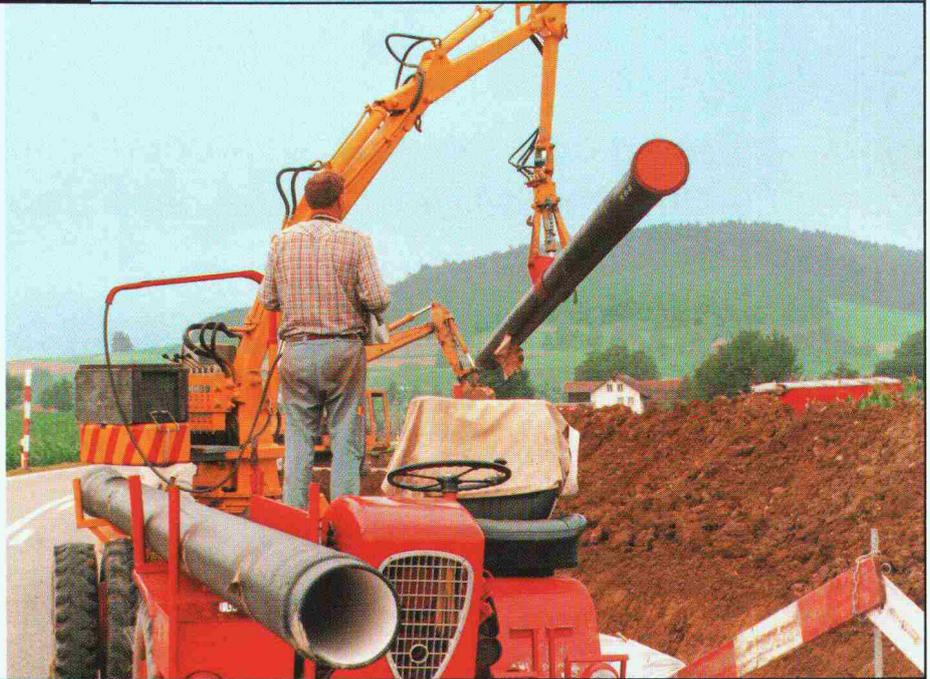
Bei abgelängten Rohren muss die FZM-Beschichtung am Spitzende auf Einstecktiefe entfernt werden. Mit geeignetem Werkzeug lässt sie sich auch unter Baustellenbedingungen mühelos und ohne Abplatzungen bearbeiten.
