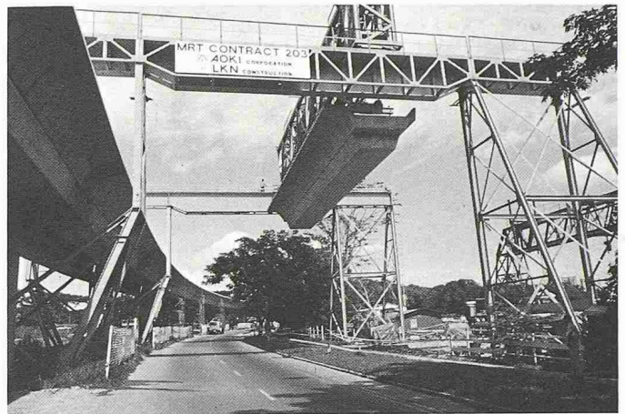
Bild 3. Brückenträger wird über die Strasse transportiert
