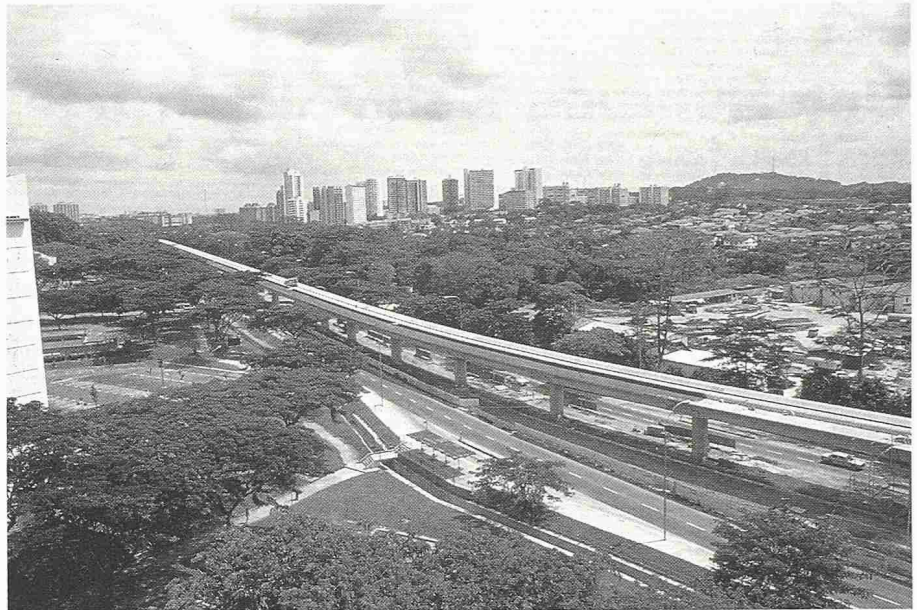
Bild 6. Fertig erstellter Viaduktabschnitt im Los 203
