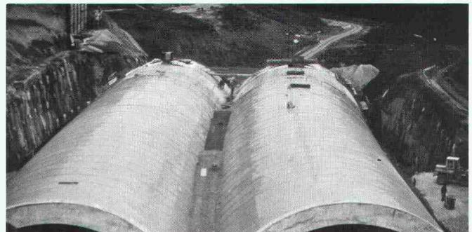
Tunnel Aichelberg, Autobahn A8 Karlsruhe-München, abgedichtet mit 7000 m<sup>2</sup> Sarnafil Typ FP 4 mm.
