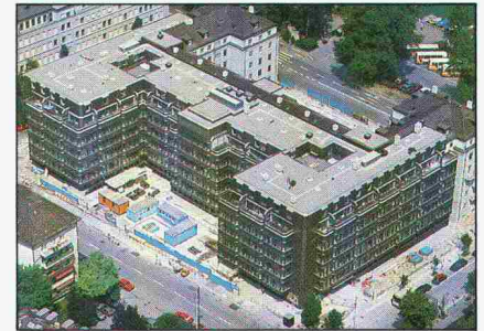
▲ Schweiz: Verwaltungsgebäude, Mythen schloß, Zürich.
