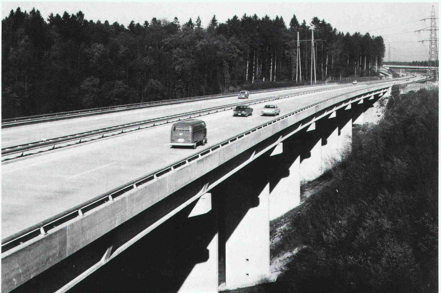
Brückendeckbelag in Beton im Verbund auf Bünztalviadukt N 1 / AG. Beratung: Betonstrassen AG, 5103 Wildegg
