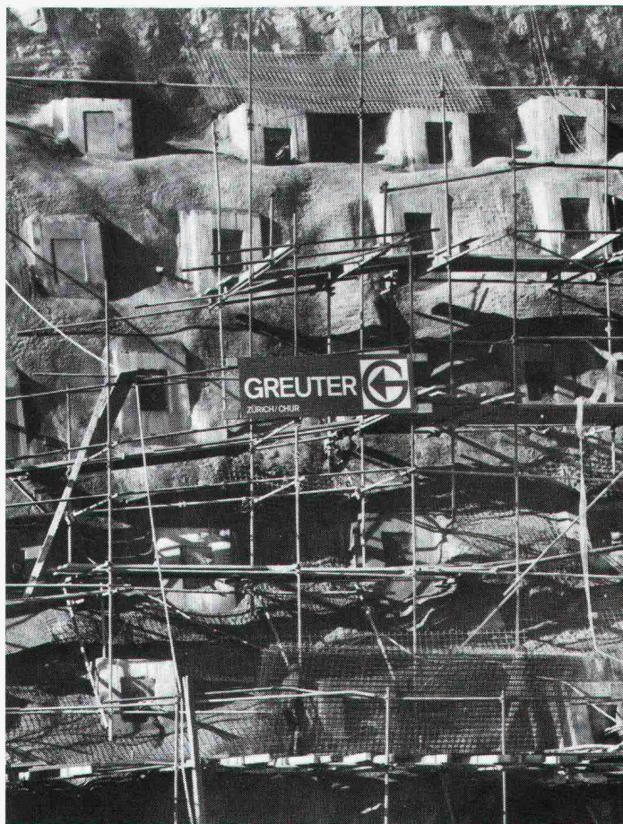
Felssicherung Dangernfluh, N2 (Eptingen)
