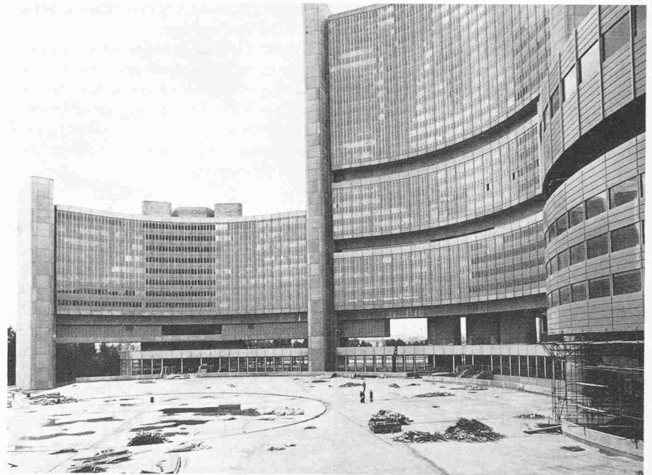
Blick von Nordosten. Unter dem Platz befinden sich die Parkdecks
