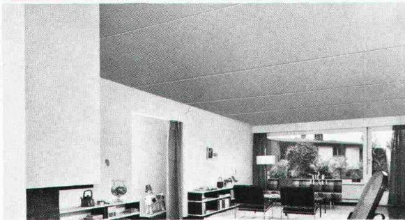
PRELAM-Deckenplatten sind grossflächige, vorgefertigte Deckenelemente, welche die Funktionen der Schalung, der Hauptarmierung und des Verputzes übernehmen.
