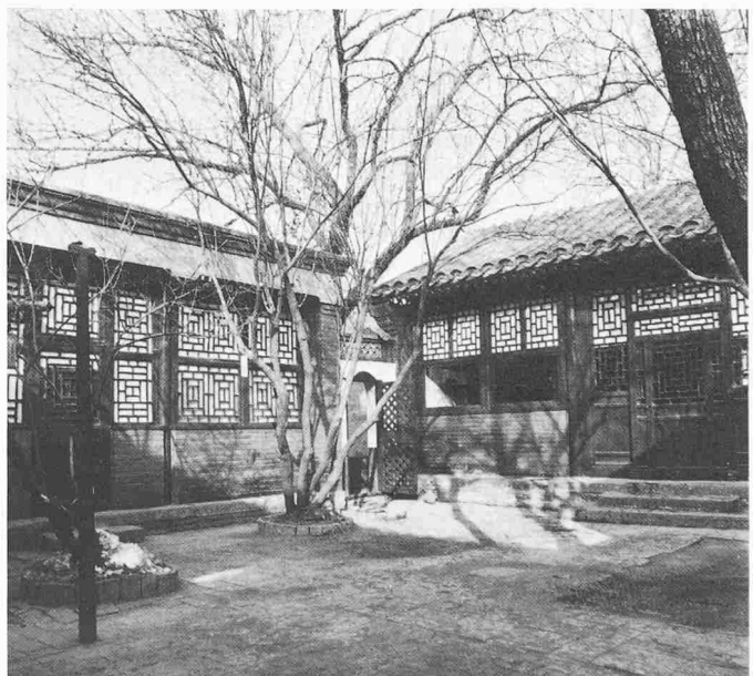
Kleines Hofhaus in Peking, ehemaliger Wohnsitz des Schriftstellers Lu Hsün, in den zwanziger Jahren bewohnt
