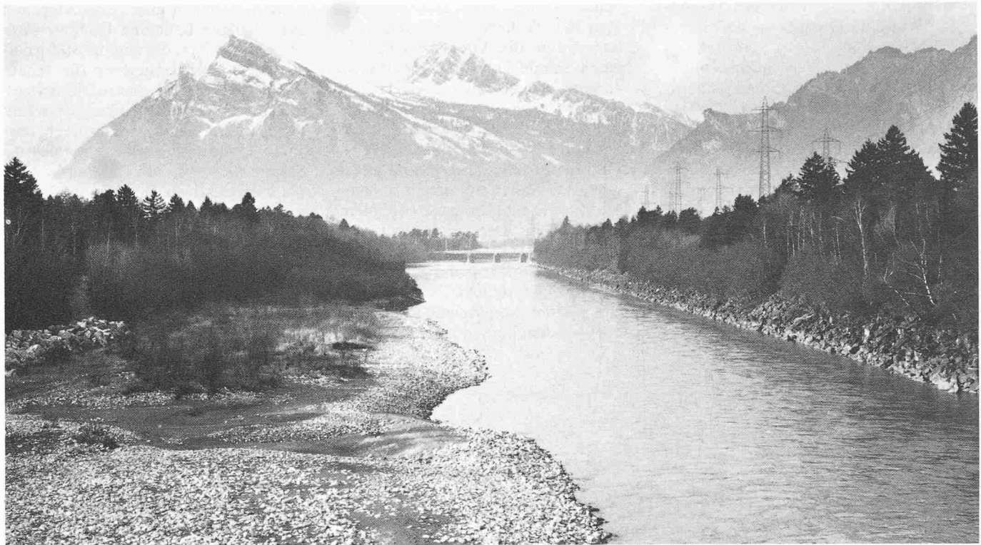
Ansicht von der Strassenbrücke Bad Ragaz-Maienfeld flussabwärts. Niedrigwasser
