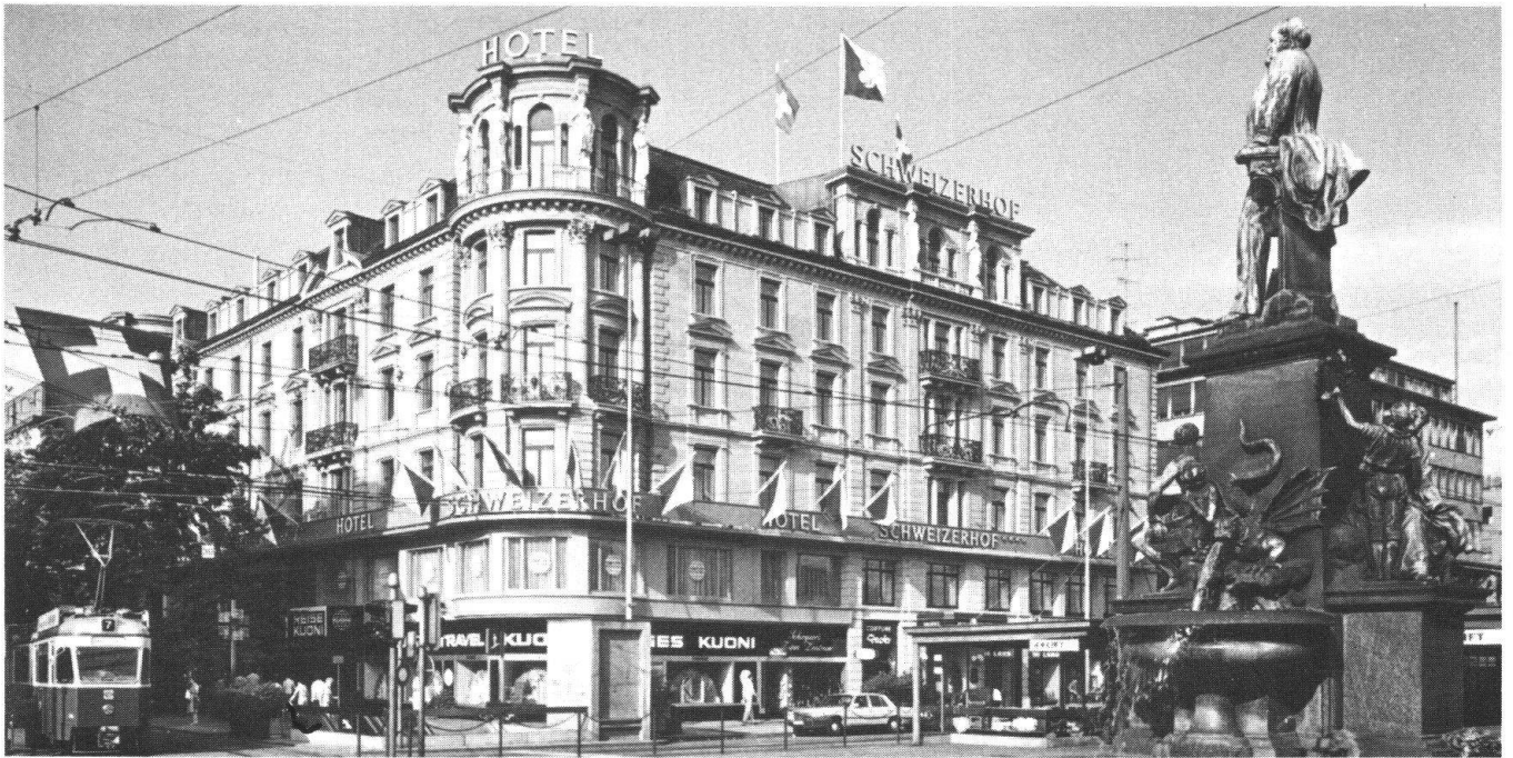
Nur noch teilweise seinem ursprünglichen Zweck dient der «Schweizerhof» in Zürich. Erdgeschoss und erster Stock beherbergen heute Geschäfte und Büros, wodurch viel von der einst prächtigen klassizistischen Fassade verlorengegangen ist. (Archivbild)
