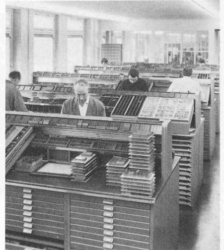
Bild 2. Teilansicht der ehemaligen Handsetzerei
