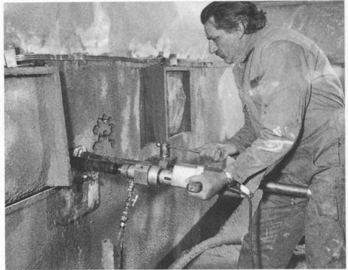
Bild 5. Entnahme von Spritzbetonbohrkernen (Foto: H. Germond, Lausanne)
