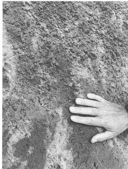
Bild 13. Unregelmässige Spritzbetonoberfläche (schwankende Rauheit)
