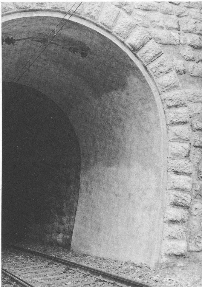
Bild 7. Unterschiedlicher Grauton («Wolkung») nacheinander ausgeführter Spritzbetonflächen
