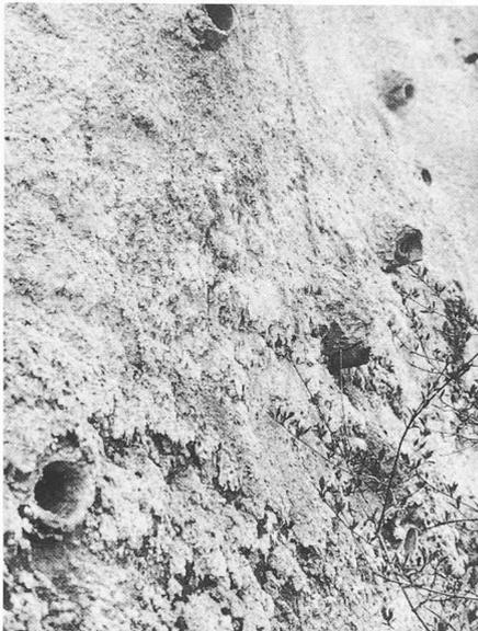
Bild 12. Unansehnliche Spritzbetonoberfläche («Überzähne»)
