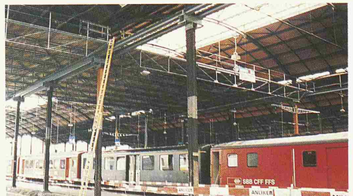
Bild 3. Schutz- und Arbeitsbühne über den Gleisen
