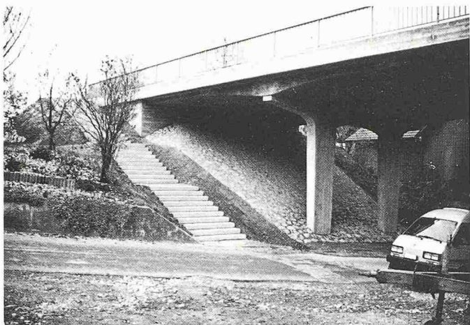
Bild 11. So präsentiert sich die umgebaute Brücke
