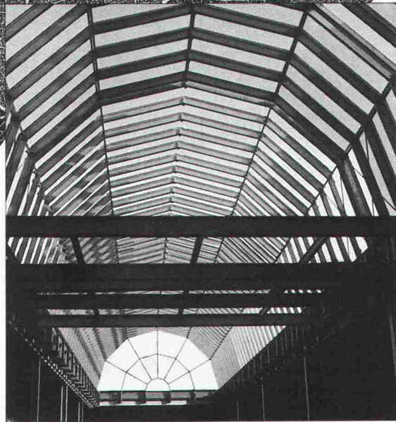
Stahl- und Industriebau
