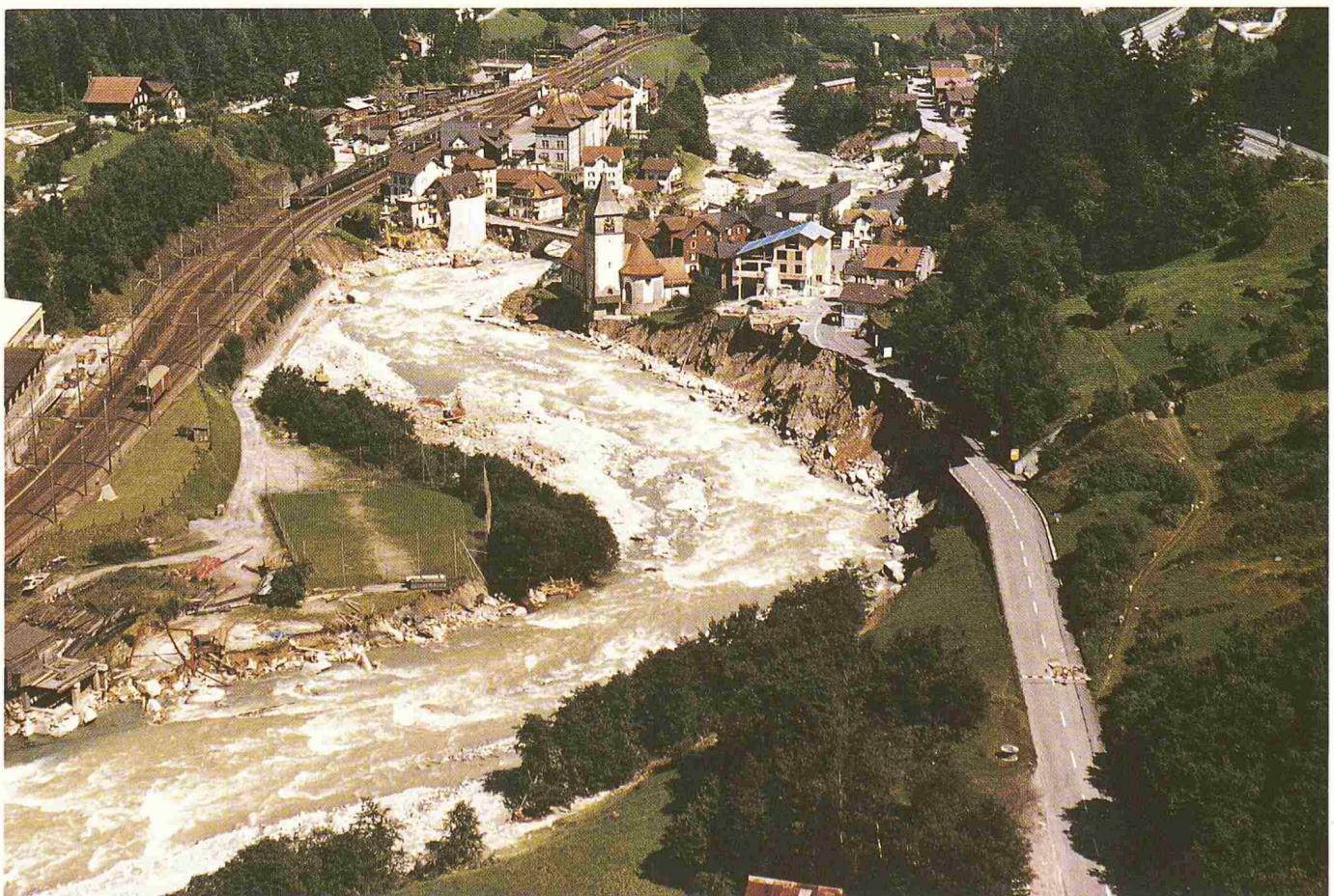
Bild 2. Gurtellen, Aufnahme vom 28. August 1987 (Foto Bauamt Uri)
