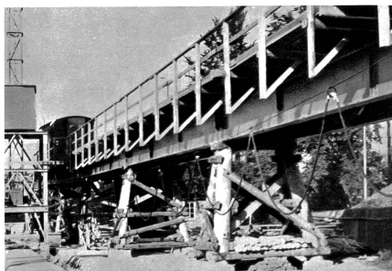
Dienstgeleise auf der Schützenmatte. Hier wird später ungefähr die neue Linie durchführen
