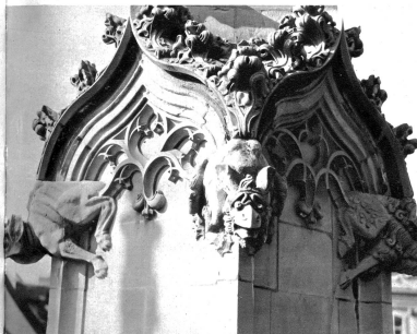
Zierwerk an einem Pfeiler
