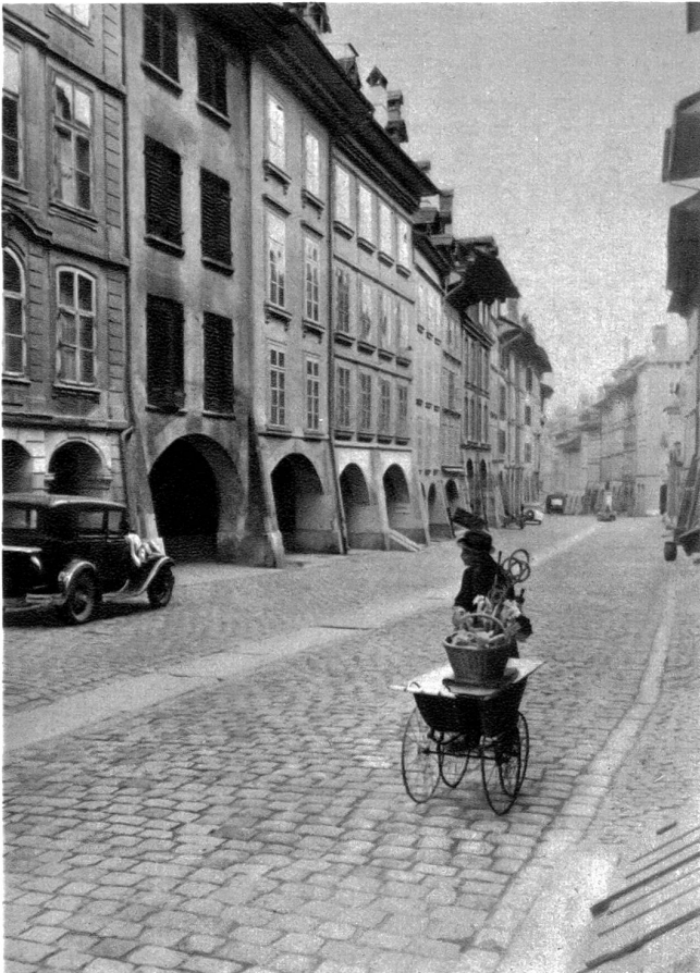
Das sog. Gespensterhaus, dessen Läden geschlossen sind
