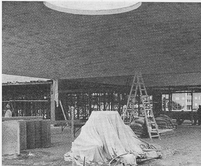
Inneres der im Rohbau fertig gestellten Buckelschalen. Die Perfekta-plattenschalung ist deutlich sichtbar
