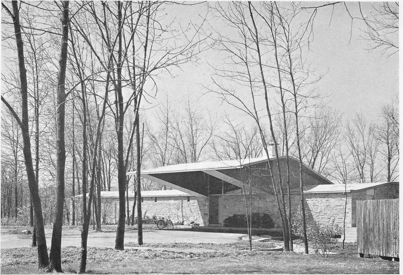
Haus D in Columbus/Ohio, Eingangsseite (Osten). Architekt Pierre Zoelly, Mitarbeiter Warren Jones, dipl. Ing., Columbus. Photo Alex von Steiger
